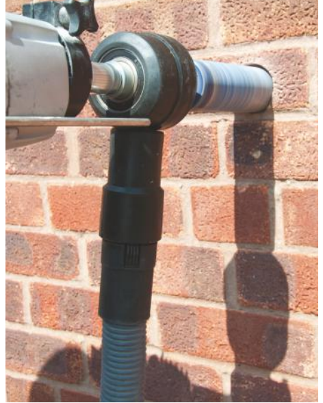
Staubreduziertes Bohren mit der Marcris Staubabsaugung*
