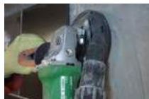
staubfreies Schleifen von Fliesenkleber
