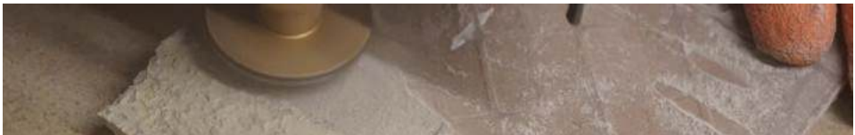
Fliesenkleber entfernen
