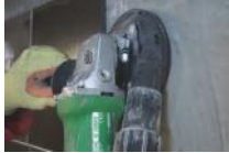
staubfreies Schleifen von Fliesenkleber
